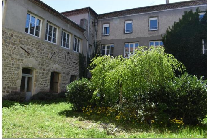
La cour intérieure mettra en valeur le Patio, sorte de maison médicale dont les premiers plateaux seront livrés en octobre 2024 aux professionnels. Photo Progrès/Olivier PIETROY
