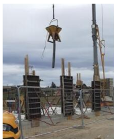
Le chantier avance route de Chambles. Photo Yvette Charret
