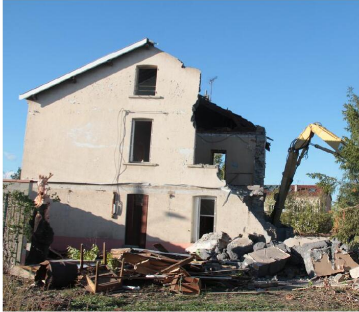
Les démolitions ont laissé la place nette pour l'édification du premier immeuble. Photo Yves Gauthier
