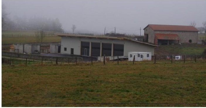
Les travaux du nouveau centre technique municipal se termineront au 1 er trimestre 2024. Photo Catherine Duculty
