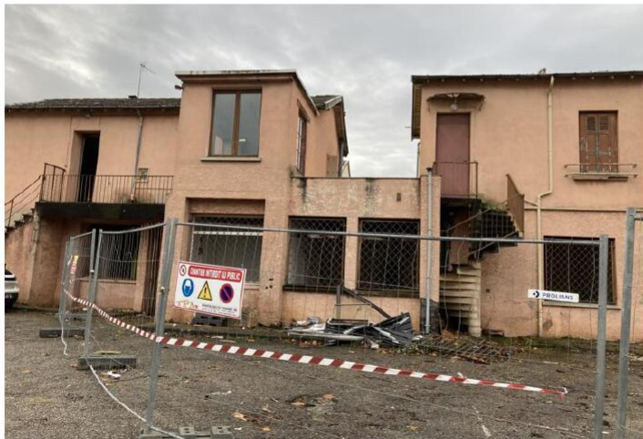
La salle Paul-Couchoud en cours de démolition. Photo Kathy Mattaliano
