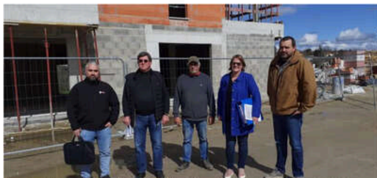
En partant de gauche M. Coskun, M. Robin, M. Brandmeyer, Mme Baudet et M. Carton lors de la réunion de chantier. Photo Yvette Charret
