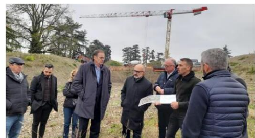
Le chantier vient de commencer sa première phase de construction de deux bâtiments. Photo Françoise Liogier
