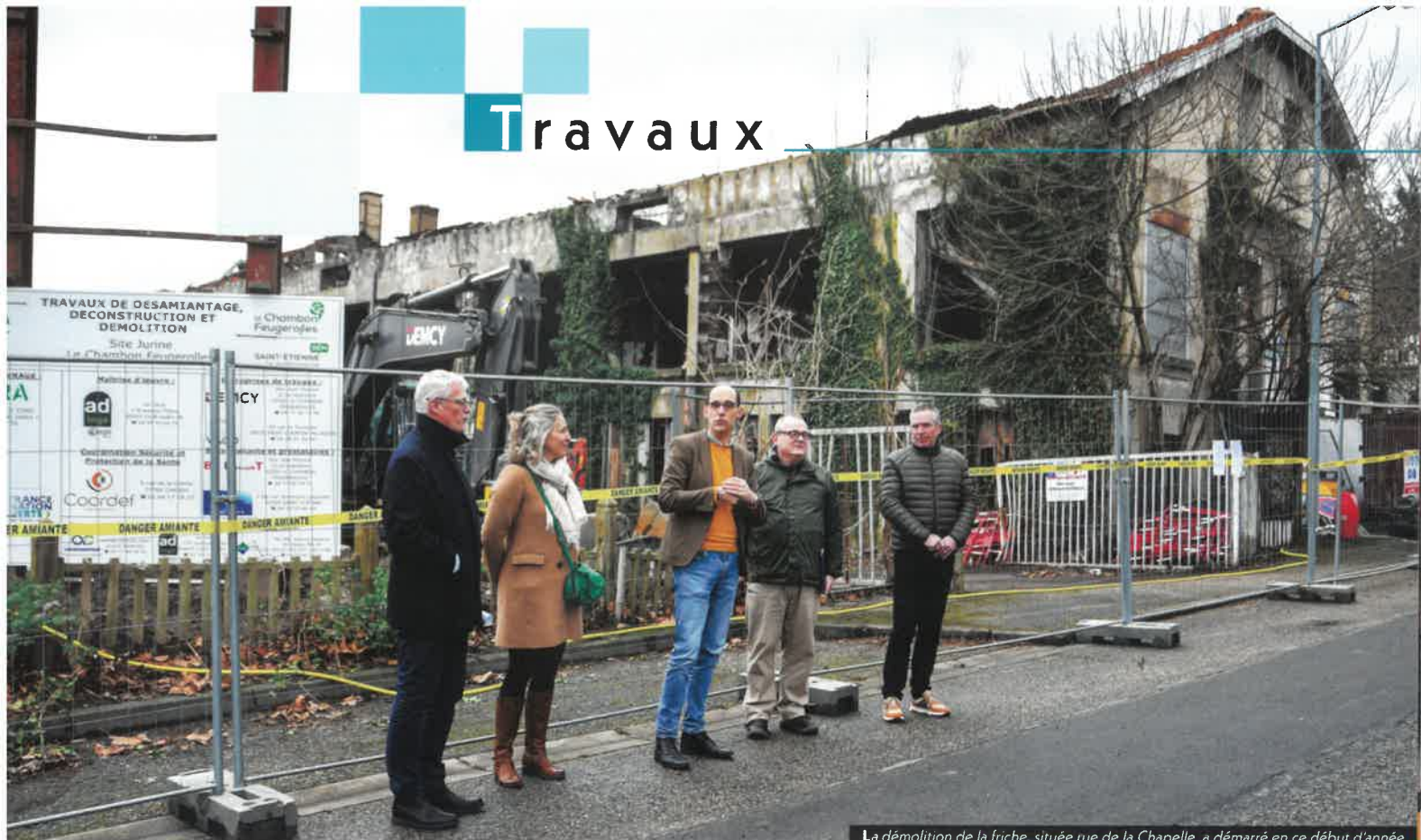
La démolition de la friche, située rue de la Chapelle, a démarré en ce début d'année
